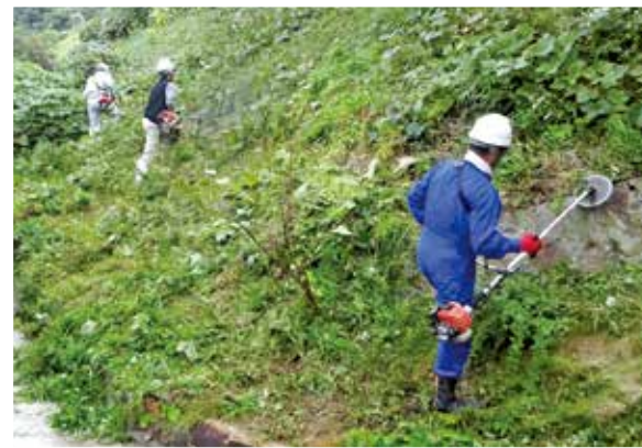
法面の草刈作業の様子
